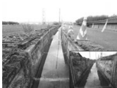
新堰幹線用水路目地改良工事
