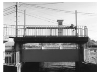
大堰幹線用水路水門整備補修工事
