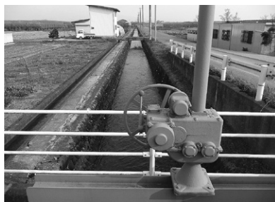
中向幹線排水路（寒河江市日田地内）
