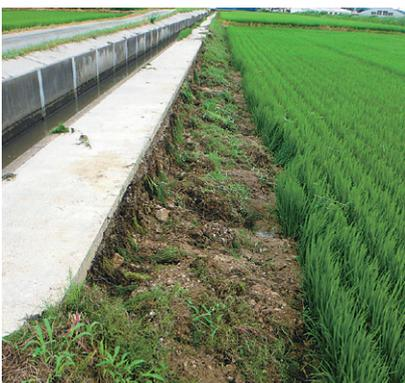
丸山堰幹線用水路 法面崩落
