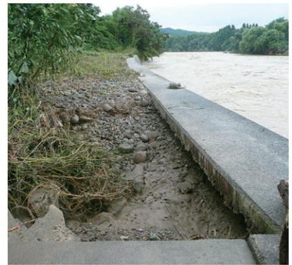
新堰頭首工 護岸天端洗掘
