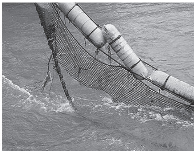
取水口に設置してある除塵用網場が破損
